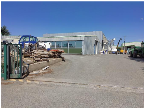
Figure 9 : Entrée du site
