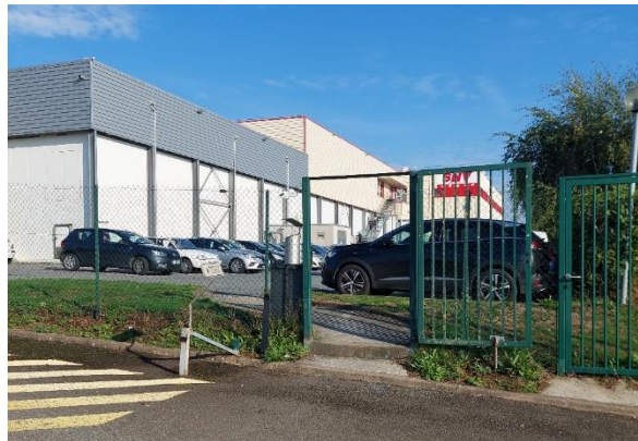
Figure 10 : Accès piétons du parking salariés n°2
