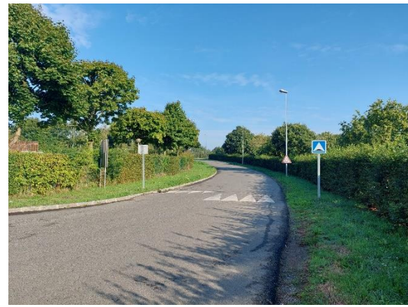
Figure 12 : Voie d'accès parking n°1 et n°2
