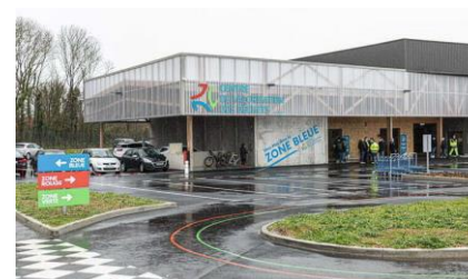
Centre Valorisation Déchets
